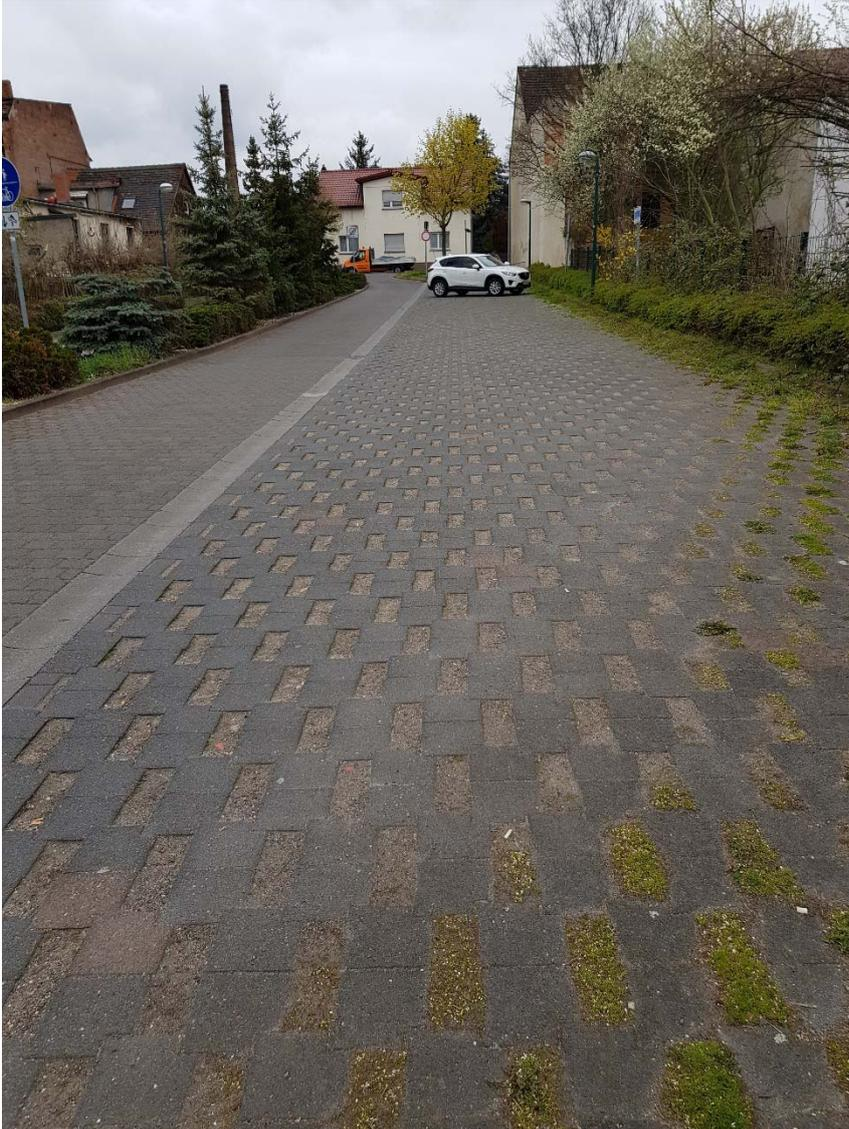
Abbildung 9: vorh. Sickerpflaster (keine Sickerwirkung mehr !!)
