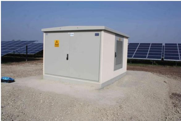
Abbildung 3.6 Beispielarstellung Trafostation
