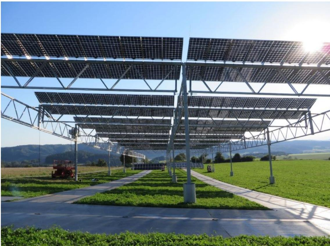
wesentlich höher aufgeständert als bei der herkömmlichen Photovoltaikanlage. Der Vorteil dieser Anlageninstallation besteht in der Doppelnutzung der in Betracht kommenden Flurstücke bzw.
