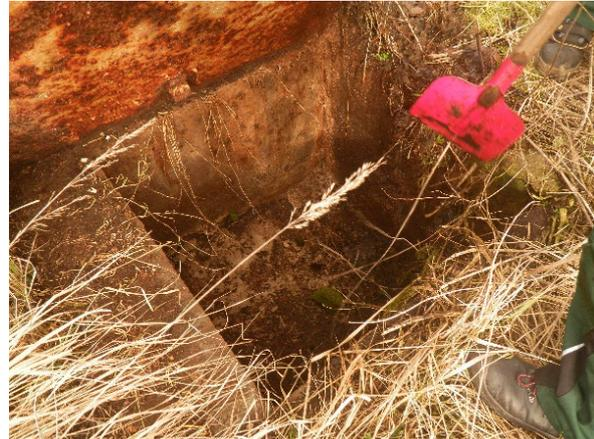
Falls die Anlage noch in Betrieb ist und der Regenwassersammler erhalten bleiben soll, ist die Leitung umzulegen und die 2 Schachtbauwerke in veränderter Lage neu zu errichten. Die DN 400 Leitung ist anzupassen. Die abzubrechenden Anlagen sind vor Abbruch und Entsorgung auf industriell bedingte Schadstoffe im erweiterten Umfang der TR LAGA für Bauschutt zu untersuchen.
