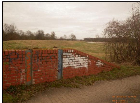
Zur Sicherstellung einer ordnungsgemäßen Deklaration der Abbruchabfälle wird eine Untersuchung des abzubrechenden Mauerwerks inkl. der Fundamente auf Schadstoffe im Umfang des Minderuntersuchungsprogramms der LAGA für Bauschutt als ausreichend erachtet. Zusätzlich wird empfohlen, die Gründungsverhältnisse der Flügelwände sowie die Abmessungen der Fundamente mittels Schürfe/Kleinbohrungen vor der Ausschreibung zu erkunden.
