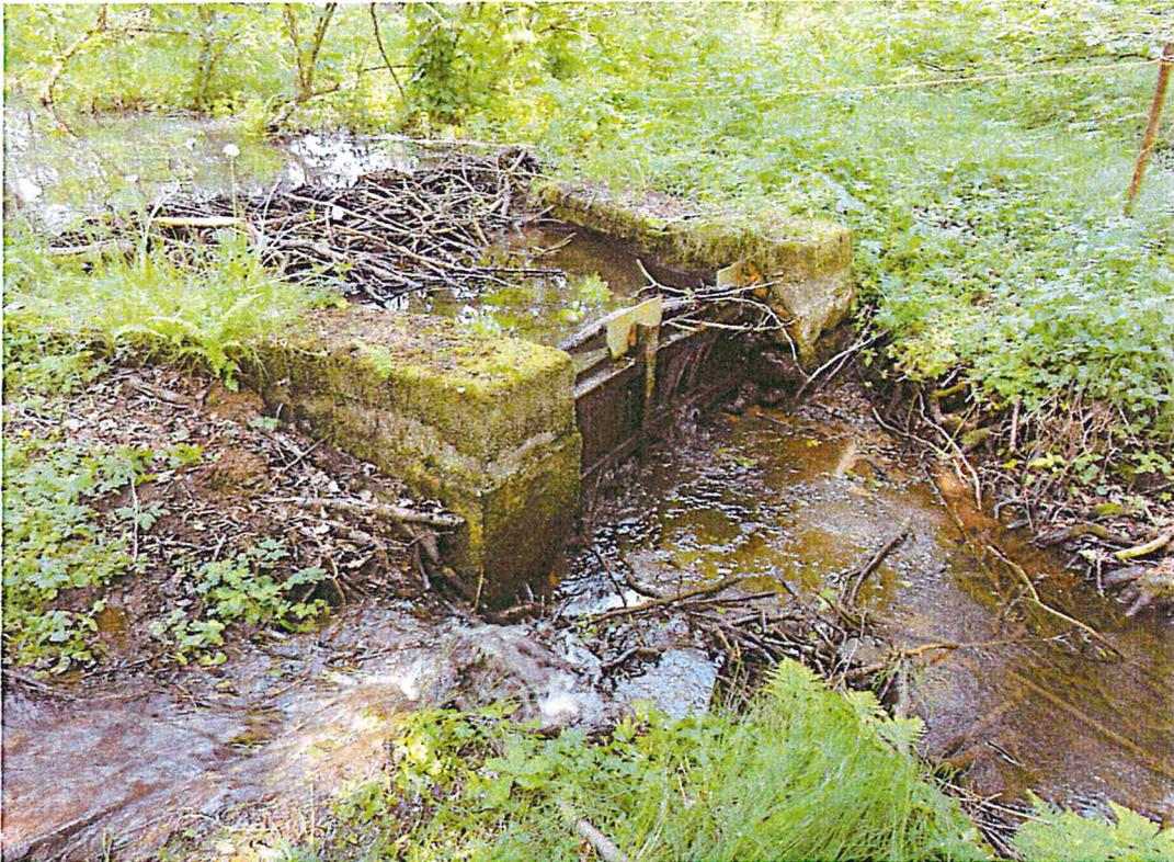
**Abbildung 5:** Stauwehr am o. g. Bypass und Rückfluss vom Mühlteich
